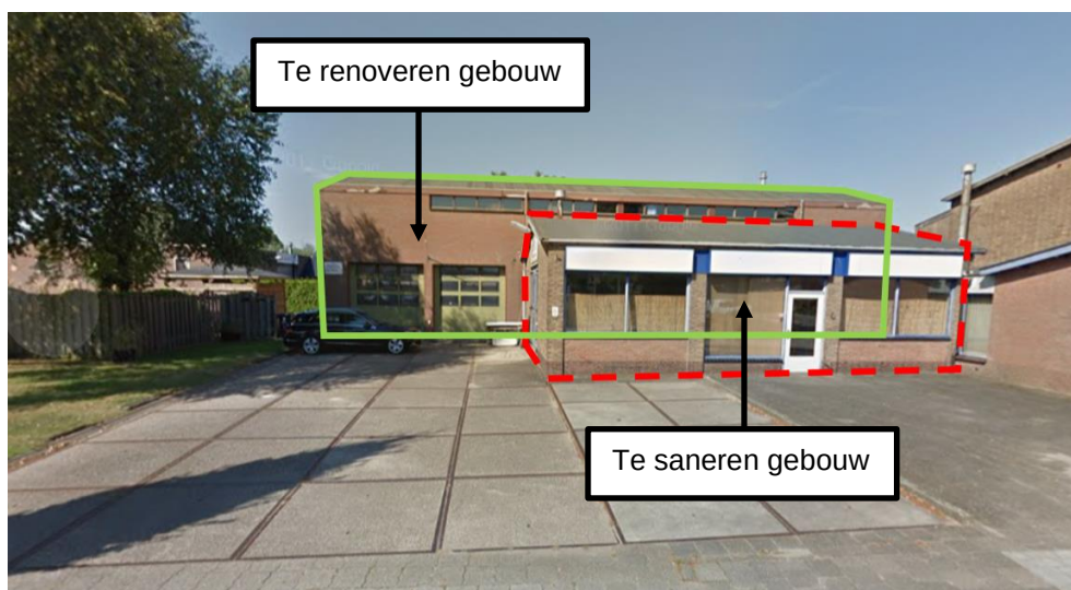
Afbeelding 4: Te saneren en te renoveren gebouwen
