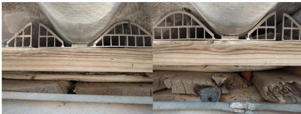
Figuur 4 Vogelschoot onder de golfplaten maakt het dak ontoegankelijk en derhalve ongeschikt als huismus nestlocatie. Daarnaast sluit de houten balk volledig aan op het vogelschroot.
