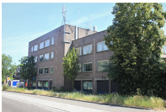
Kantoorgebouw vanaf Helsingse Achterweg.
