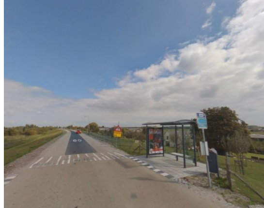
Abri voorzien van verlichting
