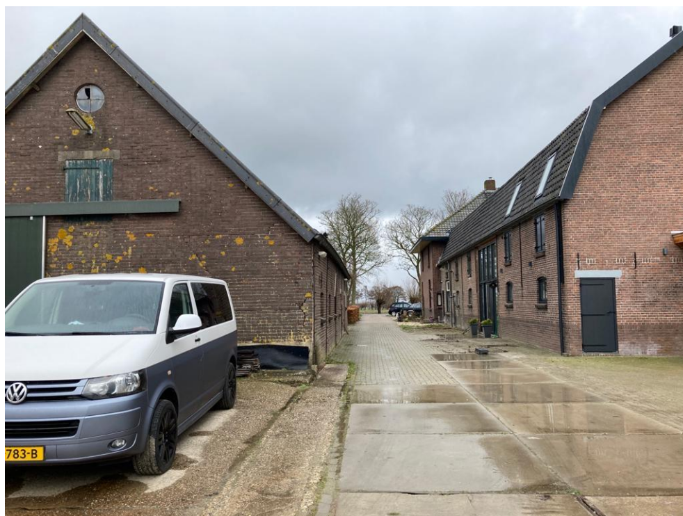
Afbeelding 10: Verharding bestaande situatie
