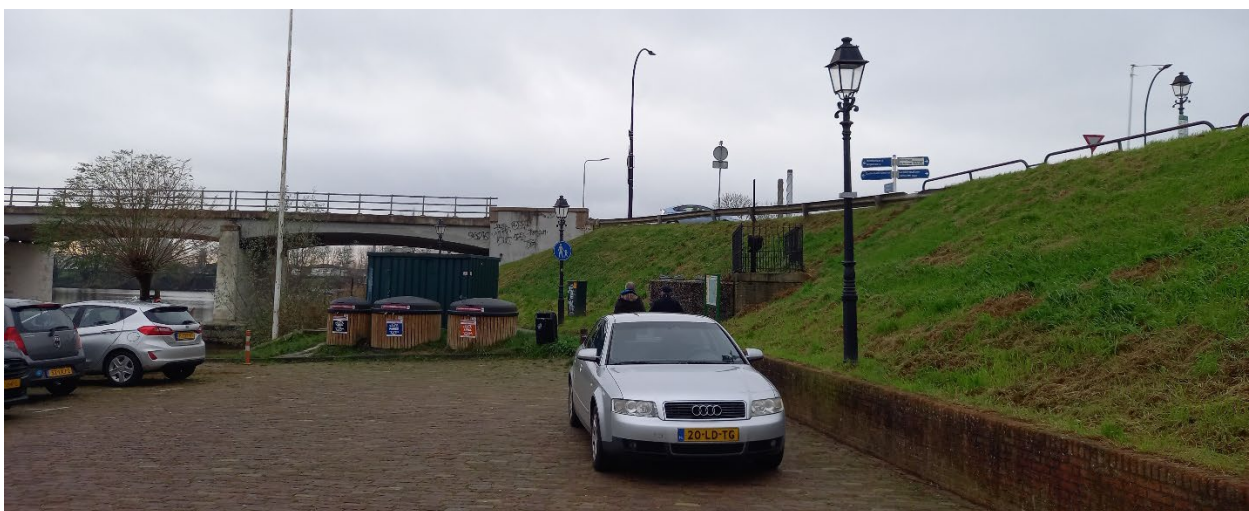
Figuur 4: Containers aan de oostzijde van de onderdoorgang
